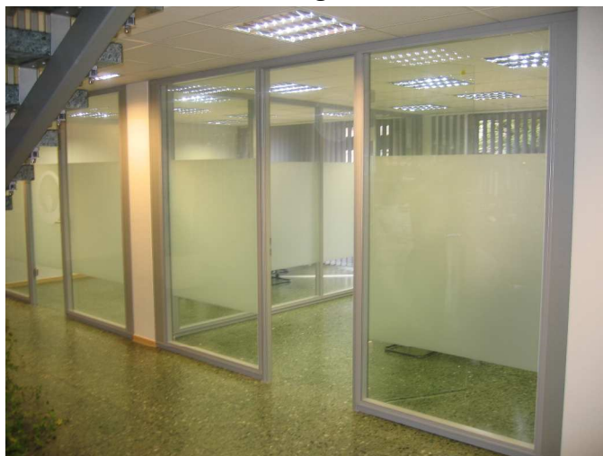
links: Programm ModulASS für die Raum trennenden Glaswände unten: Foto nach Montage
